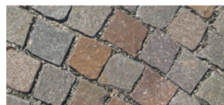
Foto: Esempi di pavimentazione permeabile (dall'alto: glielati in calcestruzzo inerbiti, grigliati plastici inerbiti, masselli porosi, cubetti o masselli a fughe strette) (fonte: Agenzia Provinciale per l'ambiente e la tutela del clima)
